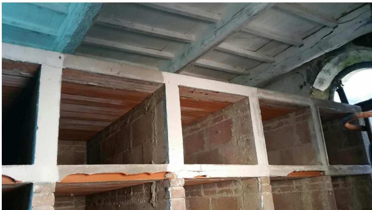
Cappellina Ovest: particolare dei forni in muratura realizzati all'interno che dovranno essere demoliti
