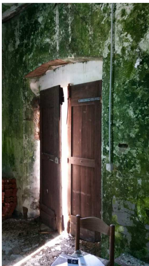
Cappellina Est: particolare interno – anche qui si nota il forte ammaloramento degli intonaci causato dalle infiltrazioni di acqua piovana
