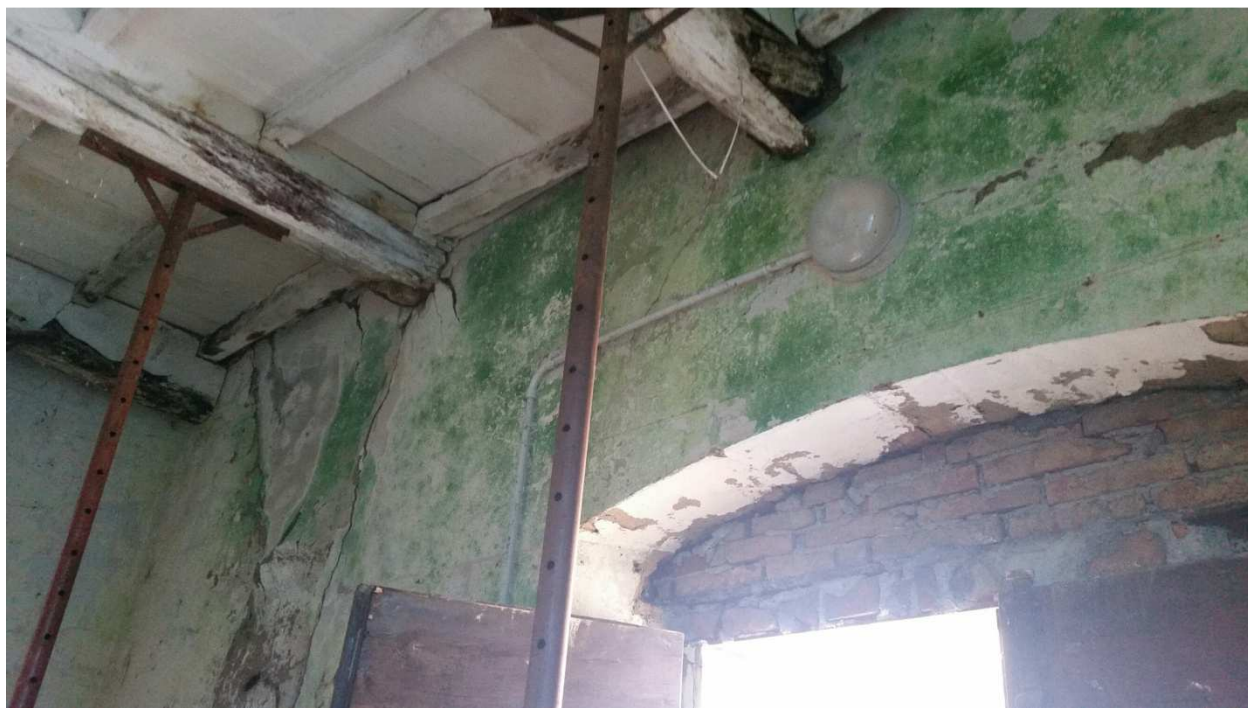
Cappellina Ovest: particolare interno – si notano gli intonaci fortemente ammalo rati a causa delle infiltrazioni di acqua e le travi del controsoffitto in legno puntellate
