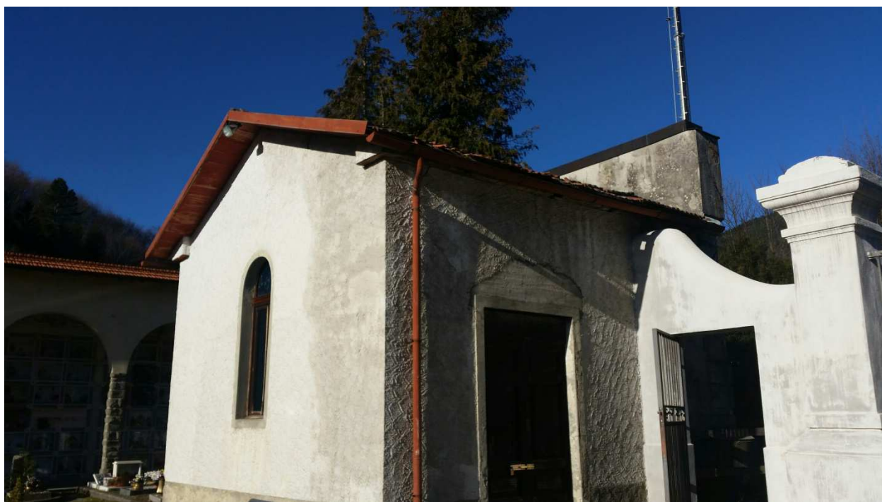
Cappellina Ovest: prospetti sud ed est (si nota la diffusa presenza di umidità sugli intonaci)
