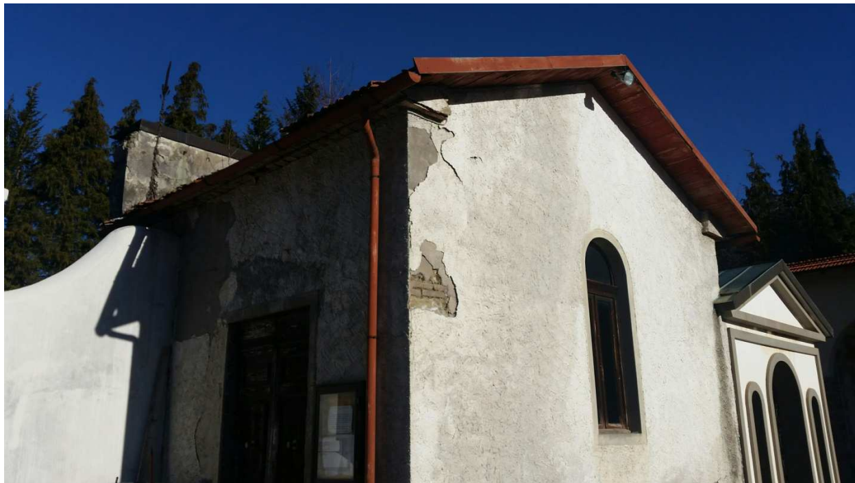
Cappellina Est: prospetti Sud ed Ovest (si nota la diffusa presenza di umidità sugli intonaci che ha già causato parziali distacchi degli stessi)
